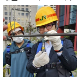
軌陸車と架線計測
